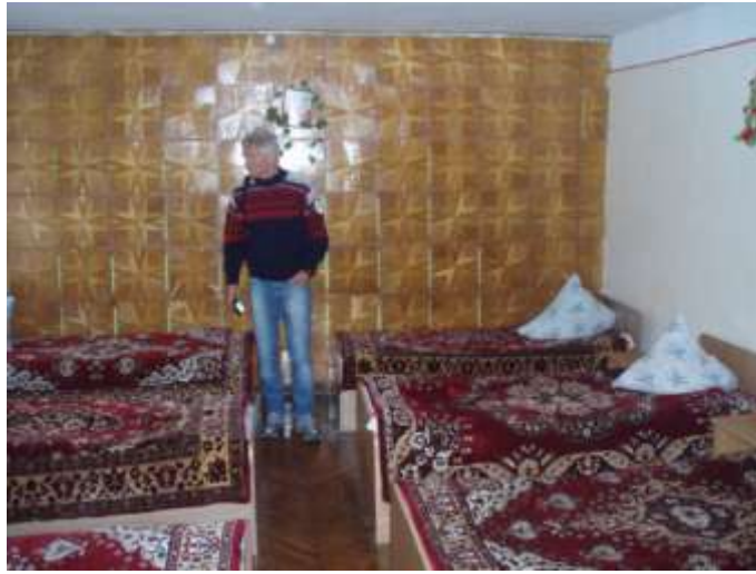
Soverommene som skal pusset opp (finans Melvold Ungdomsskole)
